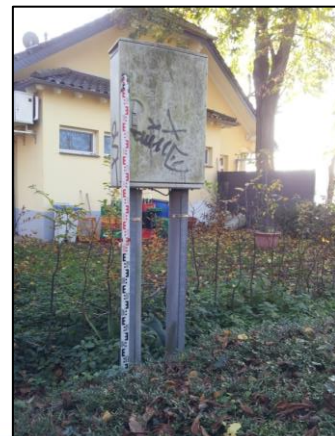
Aufgeständerter Kabelverteiler
